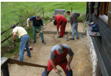
Voller Einsatz: Der Vorplatz wird erneuert.
